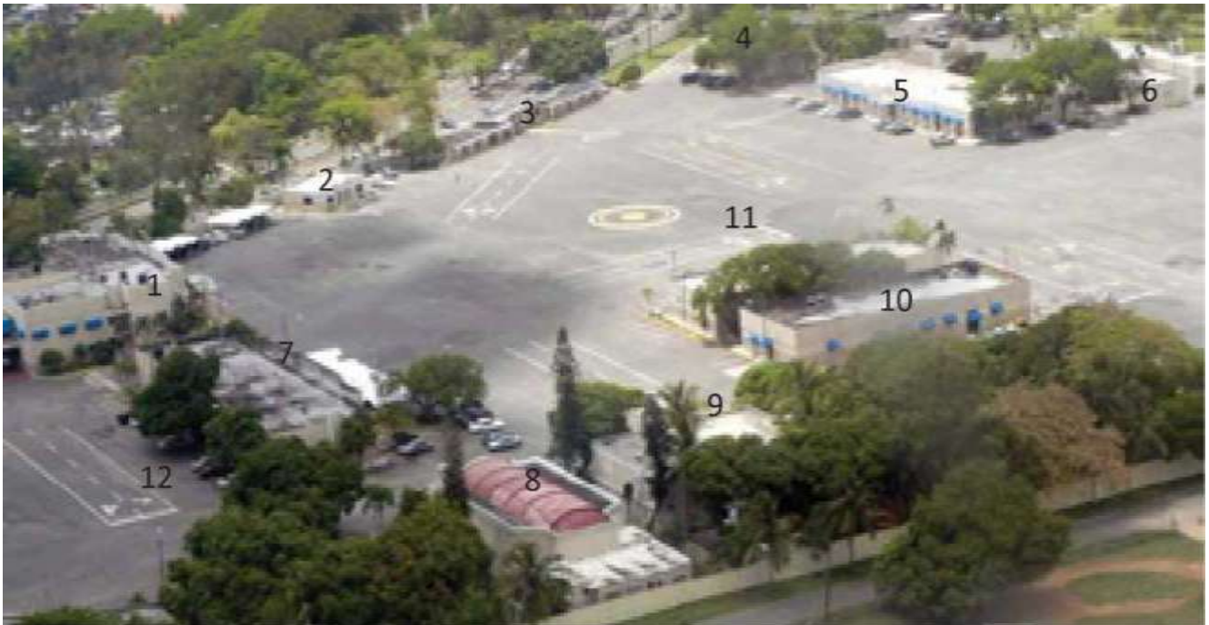
Vista aérea parcial Base Naval "27 de Febrero", M. de G; ubicada en la Av. España, Villa Duarte
