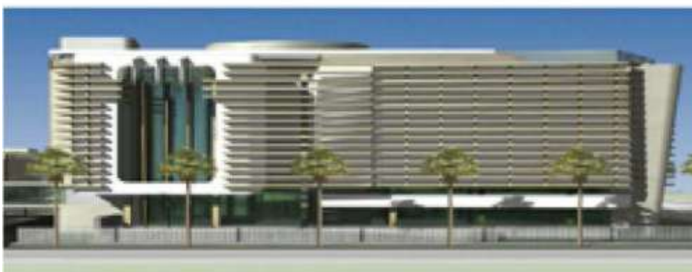
Maqueta de la nueva Jefatura de Estado Mayor, Marina de Guerra, que será construida en Sans Souci, Villa Duarte.
